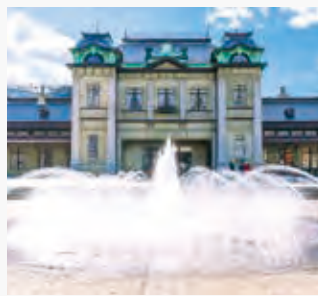
明治から昭和初期の建物が残る門司港レトポ
