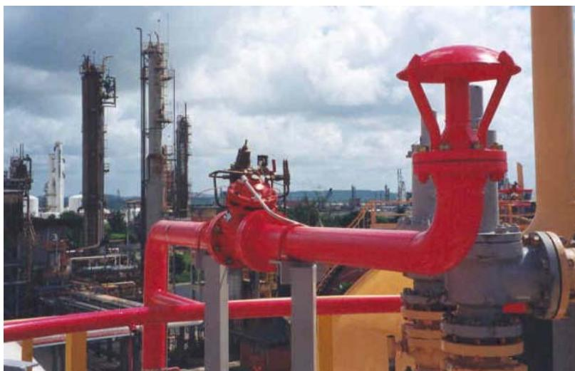
Defletor montado no topo de uma esfera, com controle através de válvula hidráulica modelo 710 (acionamento remoto)
