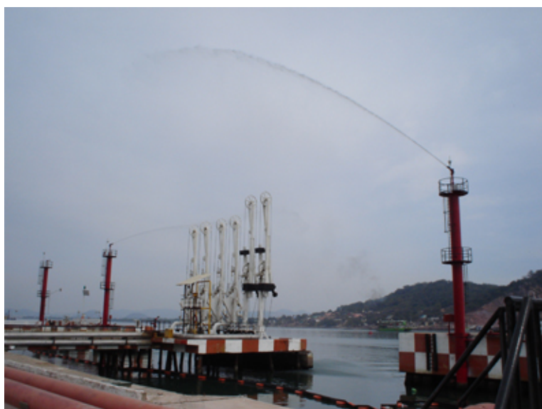
Canhões monitores modelo Conquest 3678 em funcionamento.
